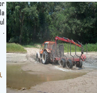
Reconstrucția albiei râului, Kopacki Rit, Croația
